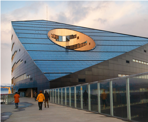
Powerhouse Brattørkaia – Sloping
